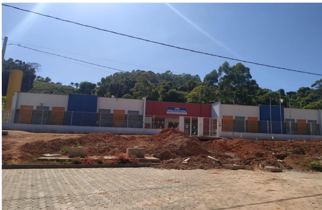
Figura 41 – Imagem das obras paralisadas em frente à escola de Educação Infantil
