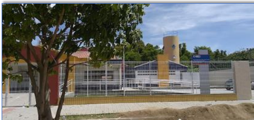
Fotografia 1 – Fachada com vista para o estacionamento
