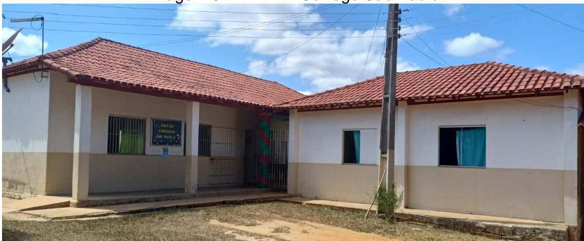
Imagem 6 – EMPEF Córrego São Paulo
