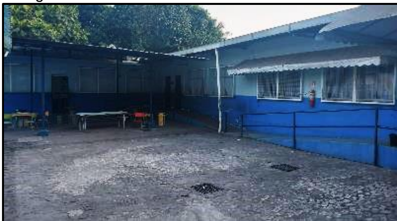
Fotografia 7 – Pátio interno e salas de aula do anexo
