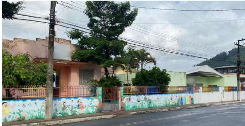
Figura 9 – Fachada do CEI “Alegria”
