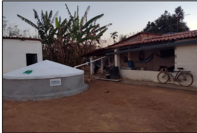
Imagem 3: Cisterna abastecida pela calha
