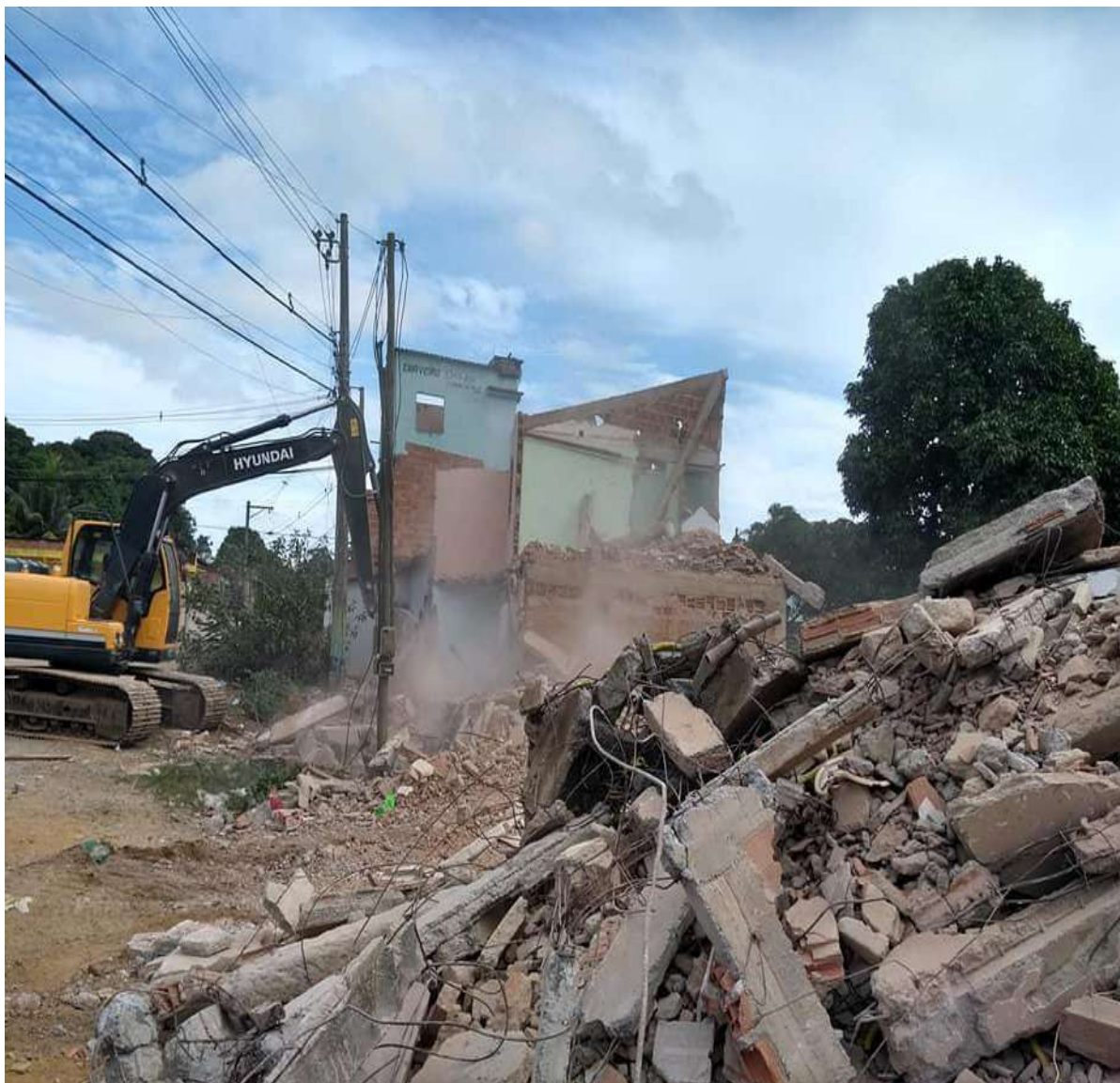
Figura 57 - Escavadeira removendo casas nas margens do Rio Formate/Tacoarê
