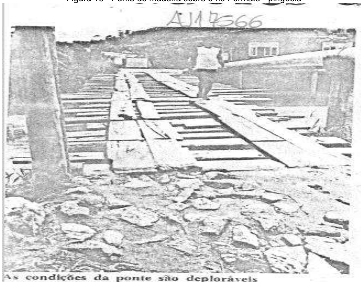
Figura 10 - Ponte de madeira sobre o rio Formate - pinguela
