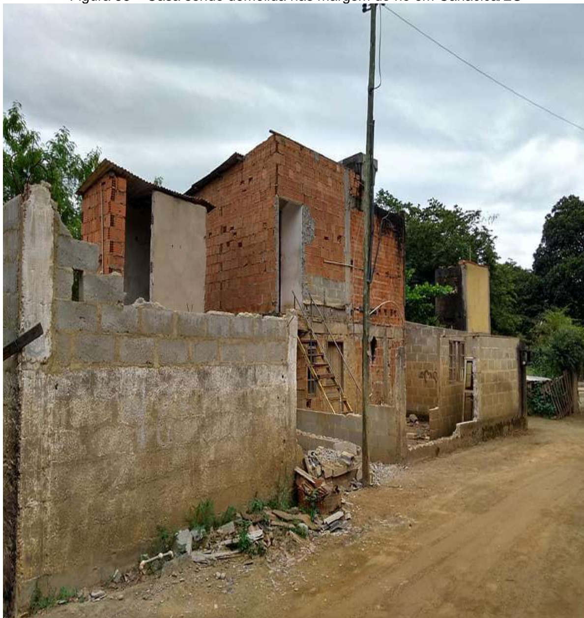
Figura 58 – Casa sendo demolida nas margem do rio em Cariacica/ES
