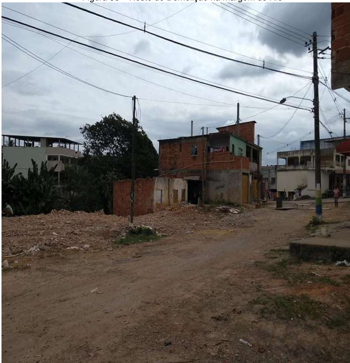
Figura 56 – Resto de Demolição na margem do Rio
