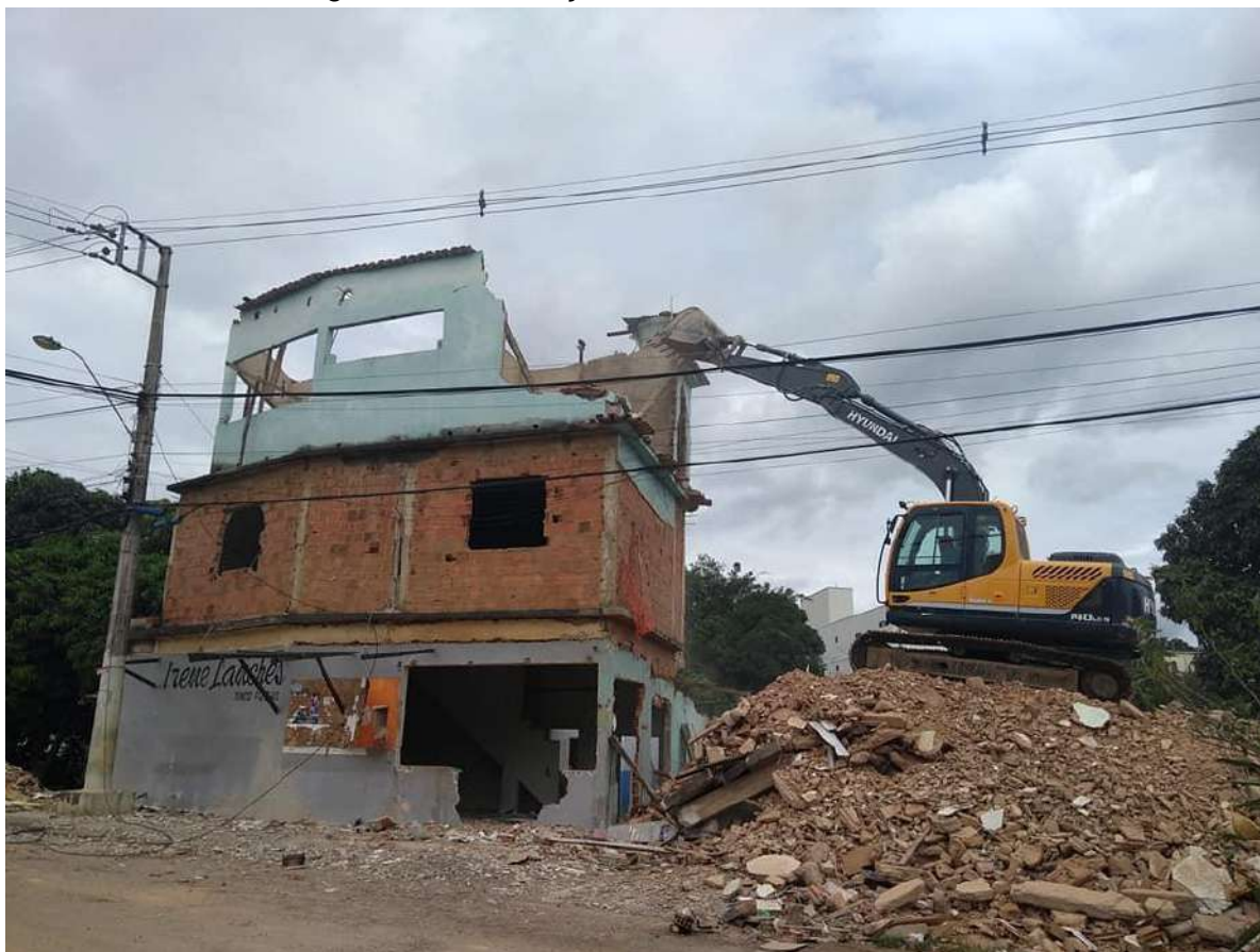
Figura 21 – Demolição do sobrado da Lanchonete
