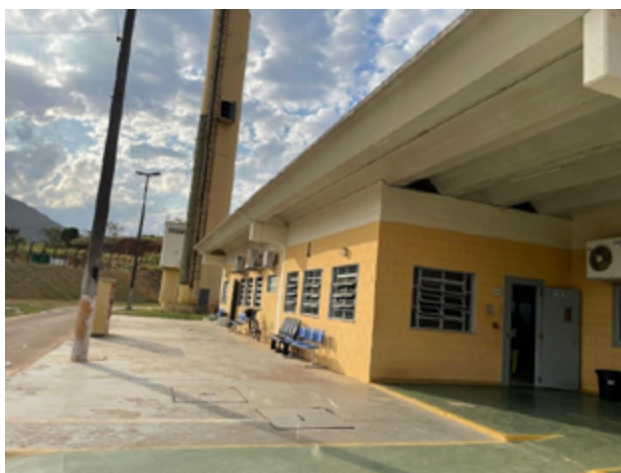
Área externa da unidade prisional
